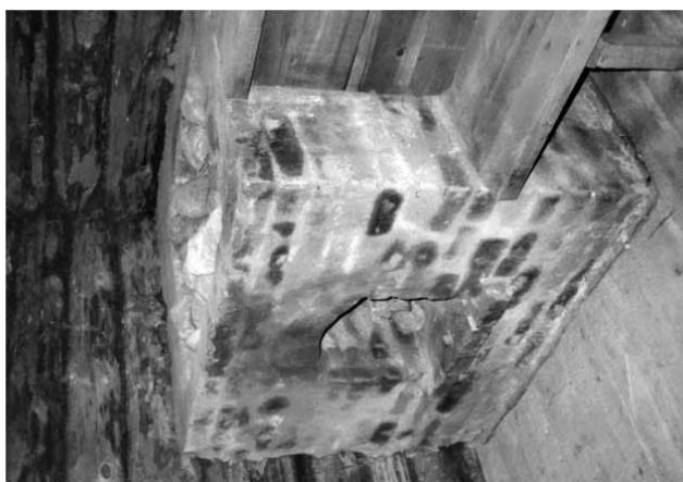
Рис. 17. Реконструкция печи, топившейся «по-черному». Экспонат бывшего КОИИМЗ «Ипатьевский монастырь», отдел «Деревянное зодчество»
