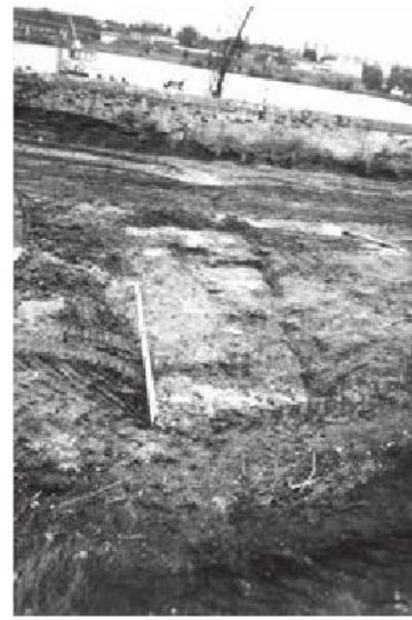
Рис. 3. Площадка строительных земляных работ до начала археологических исследований. Вид с ЗЮЗ
